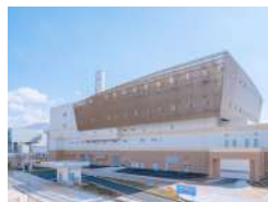
ながの環境エネルギーセンター 【長野市】
